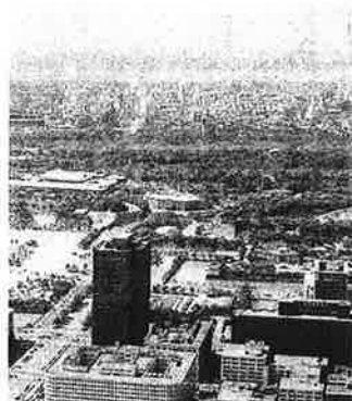
②完成翌年の東京海上日動ビル。皇居を見下ろし、遠くに新宿副都心の超高層ビル群が見える＝1975年 ③解体工事の進む東京海上日動ビル(手前中央)。背後には高さ200m近い新丸ビルがそびえる＝3月20日
