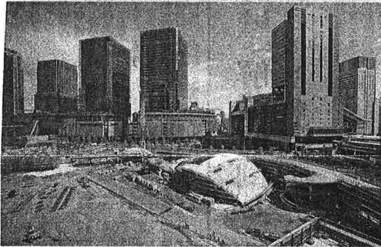
報道陣に公開された「うめきた公園」の建設地—25日、大阪市北区（甘利慈撮影）
