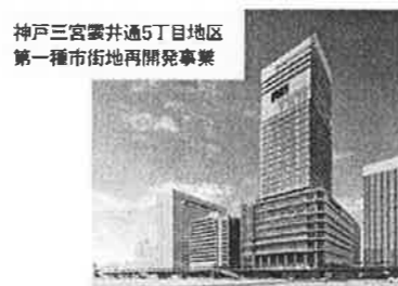
神戸三宮駅通5丁目地区 第一種市街地再開発事業 画像提供/豊井通5丁目再開発株式会社
