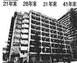
解体前の浜松町ビジネスマンション =三井不動産提供
