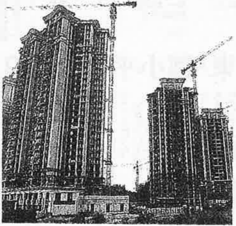
建設中のマンション ＝9月、広東省仏山市
