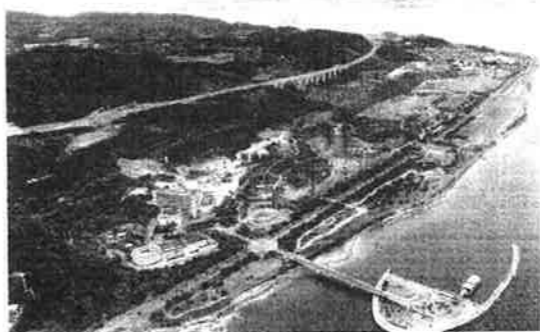
パソナグループは淡路島北部を中心に多くの拠点を有し、複合リゾート施設の淡路夢舞台(左手前)にもオフィスが入る(兵庫県淡路市で、本社へ移す) 原田拓未撮影
