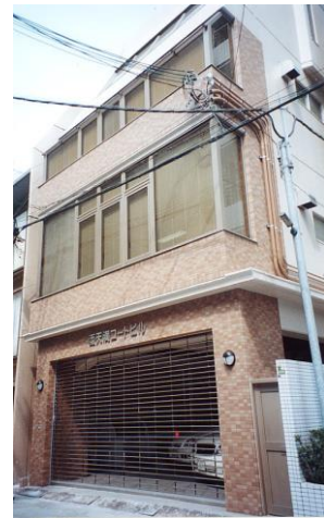
西天満コートビルの外観
